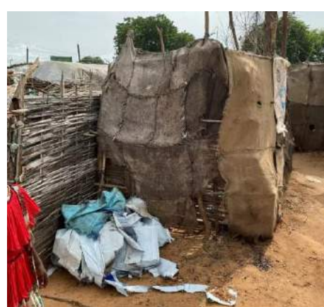
Latrine dans un site de déplacés, site de Al-Genaina, 2022
