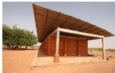
La majorité des écoles au Burkina Faso sont construites en ciment, ce qui augmente les coûts de construction et le gaspillage d'énergie électrique. La construction de l'école primaire de Gando, commencée en octobre 2000, réalisée en grande partie par la population et terminée en juillet 2001. Le projet est basé sur des concepts garantissant sa durabilité : confort climatique assuré, coûts limités, matériaux locaux utilisés. La communauté est consultée et participe au projet.
