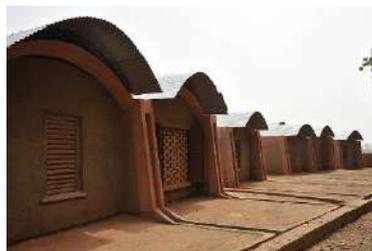
**Logements pour enseignants** : La configuration courbe rappelle l'architecture typique des édifices burkinabés. Chaque logement se compose de trois murs parallèles de briques de terre stabilisée. Ces murs soutiennent des voûtes en berceau réalisées avec des blocs de terre stabilisée. Pour protéger l'édifice de l'humidité du sol, les épais murs de briques crues reposent sur des fondations de ciment et de granit. Les toits sont réalisés à différentes hauteurs.
